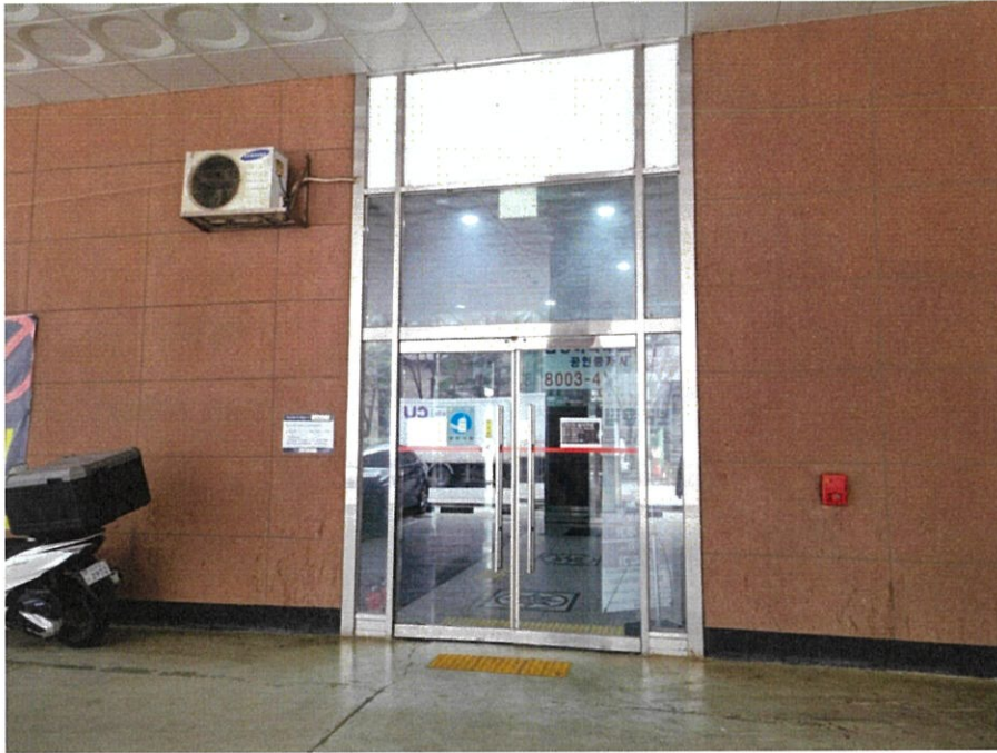
본건 건물 1층 출입구
