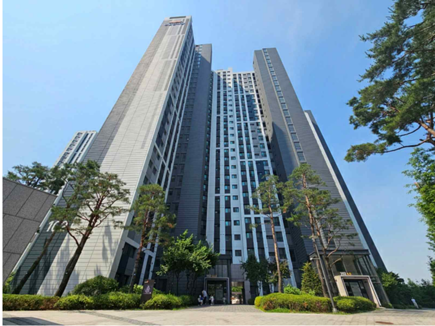
본 건 건물 전경 - 본건 북동측에서 촬영
