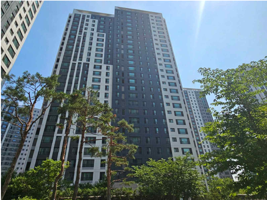
본 건 건물 전경 - 본건 남서측에서 촬영
