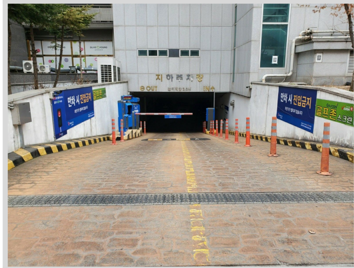
본건동 주차장 출입구
