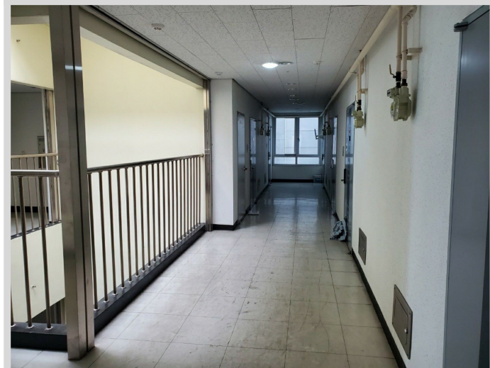
본건 9층 복도 전경
