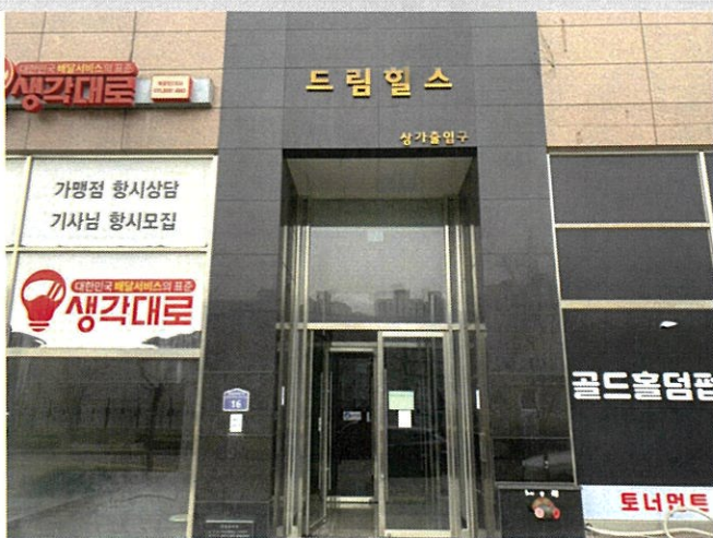
본건 공동현관 전경
