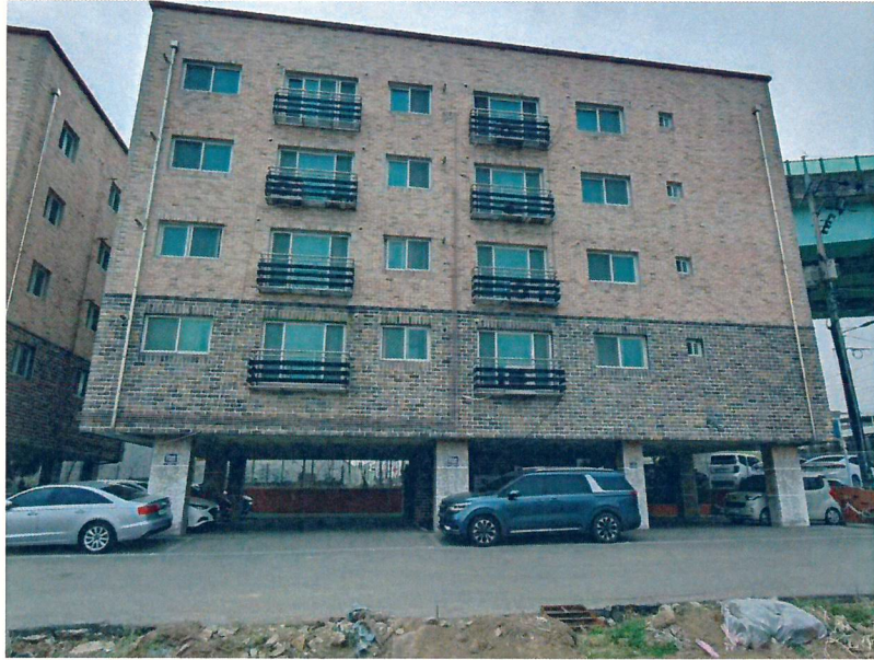
본건 건물 전경 (남동측에서 촬영)
