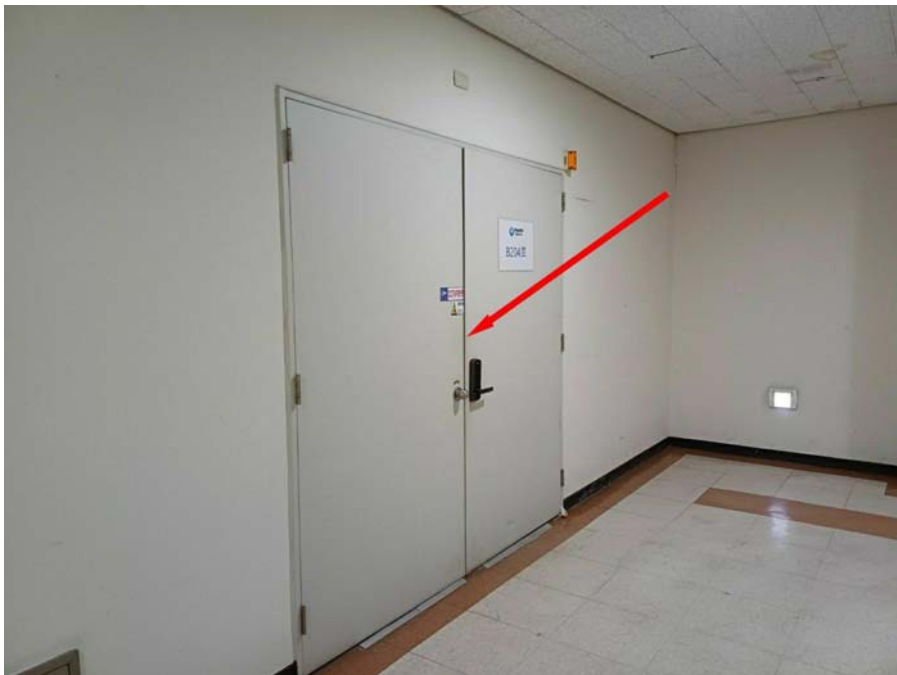
기호(2) 비204호 출입문 전경
