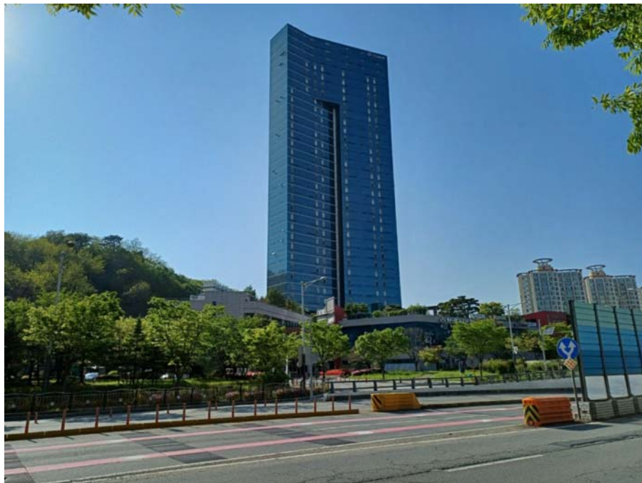
본건 건물 전경
