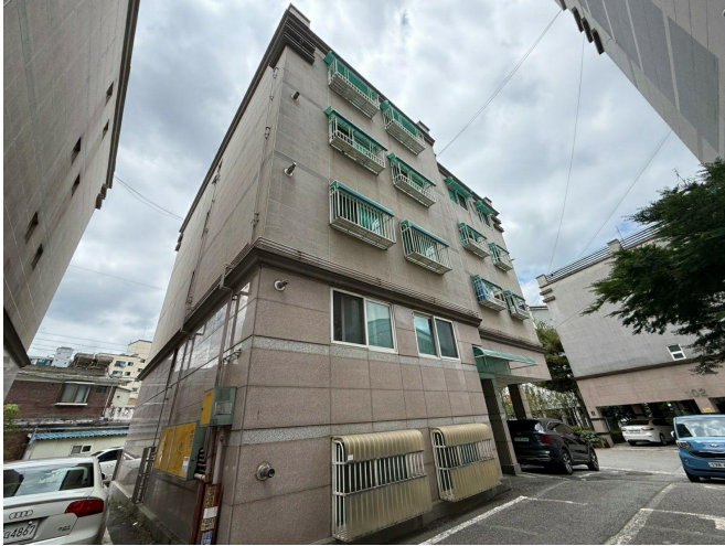
[ 본건 제103동 전경(북동측) ]
