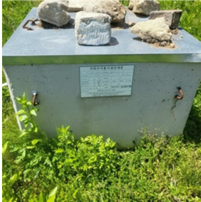
지하수 보호대 전경
