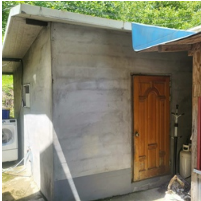
제시외 건물 ㄴ 전경
