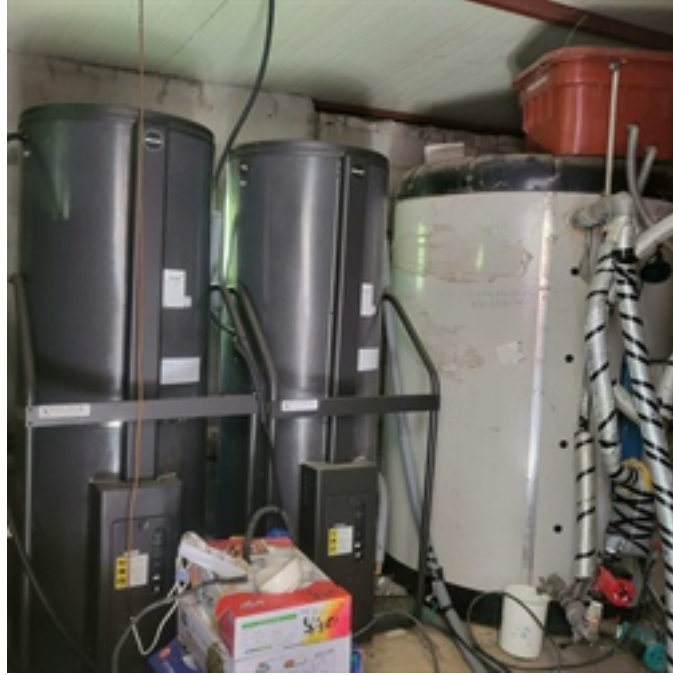
제시외 건물 ㄴ 내부 전경
