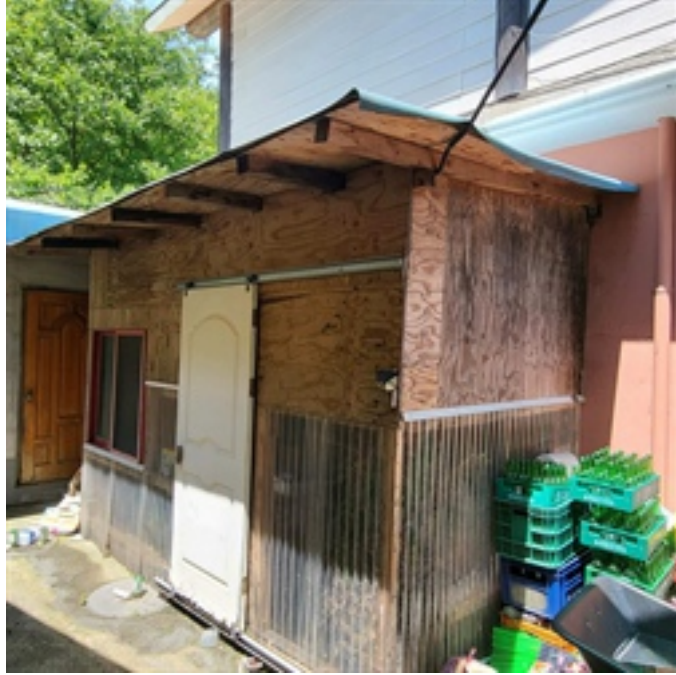
제시외 건물 ㄱ 전경
