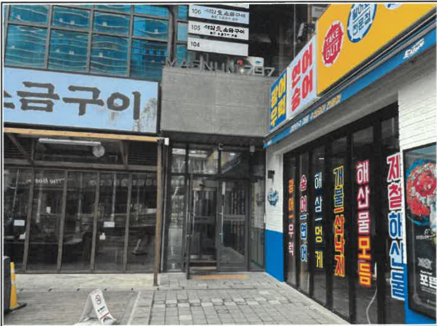
대상물건 건물 출입구 전경
