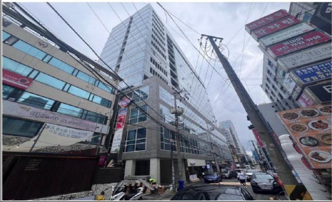
본건물 전경(북동측에서 촬영)
