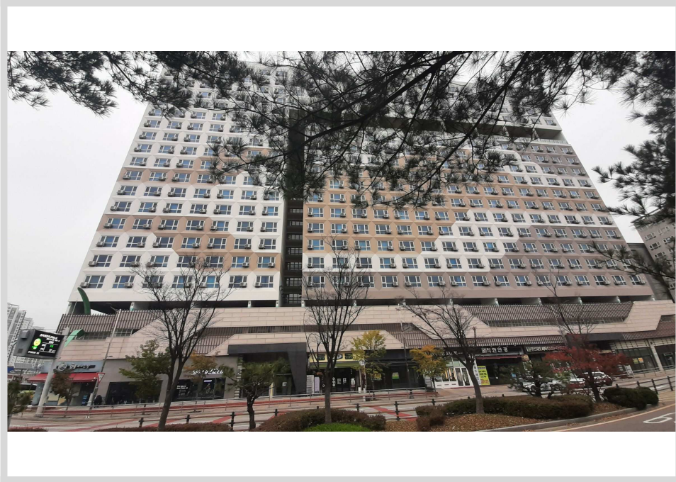
<본건 건물, 남서측 촬영>
