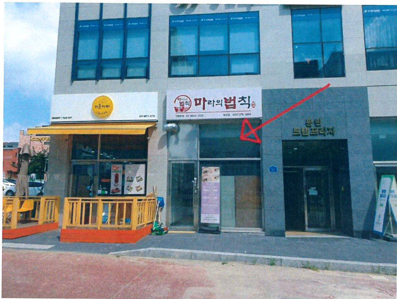
본건(105호) 및 건물 서측출입구
