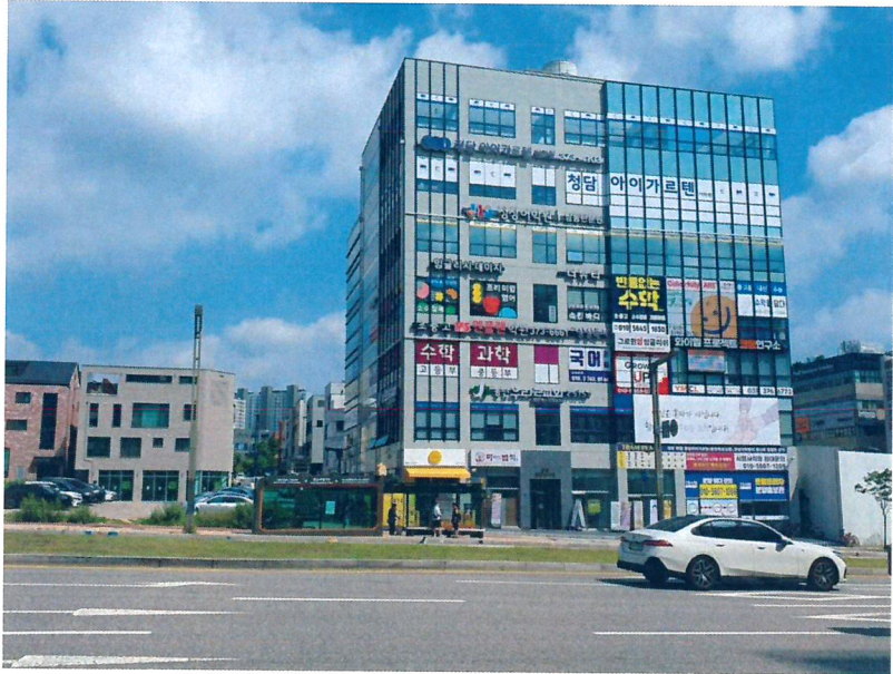
본건이 속한 전체건물 전경
