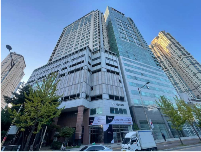
본건 건물 전경
