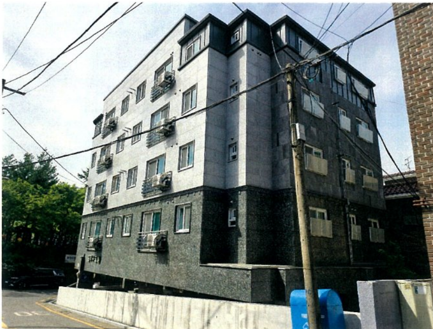
본건이 속한 건물 전경(북동측)
