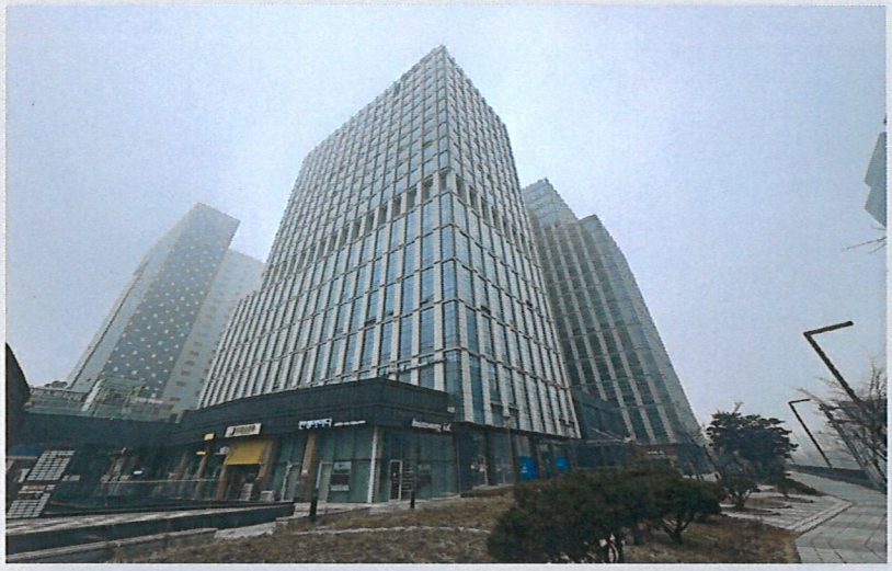
본건 건물 전경
