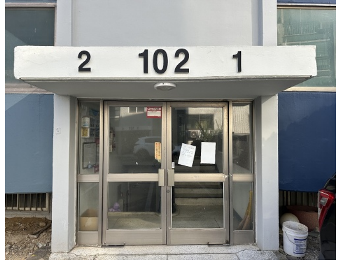
[본건 1층 출입구]
