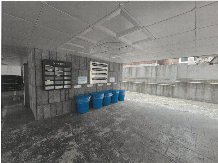
본건 1층 필로티
