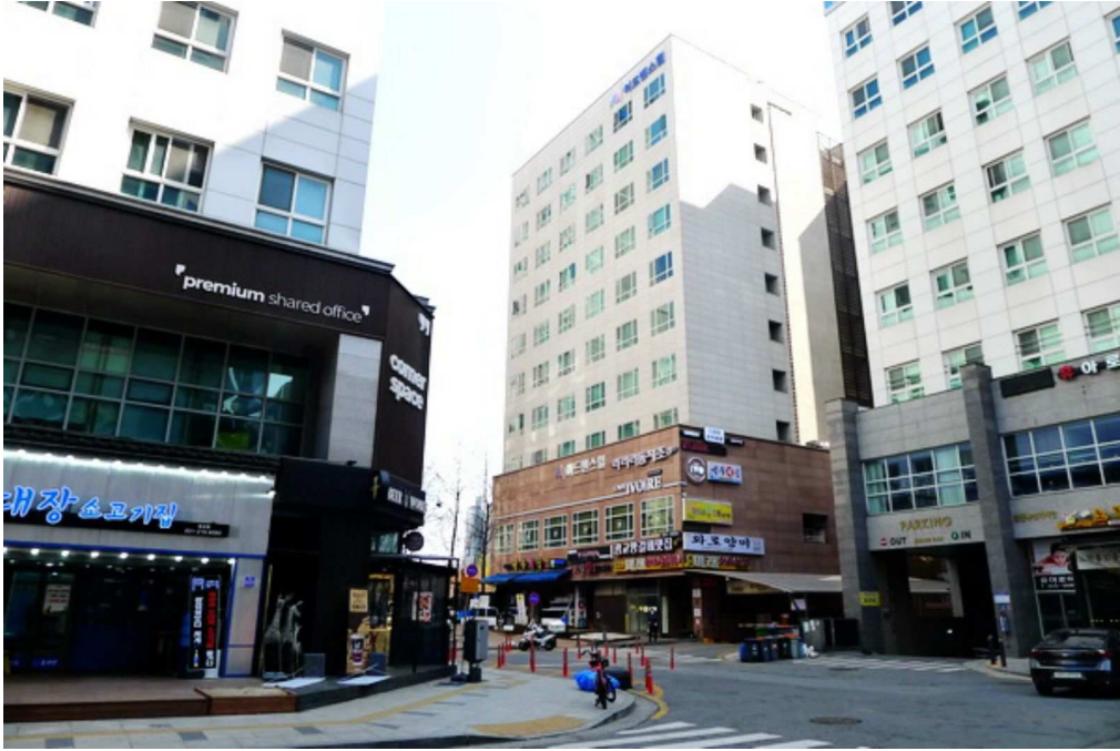
집합건물 전경 북서측에서 촬영
