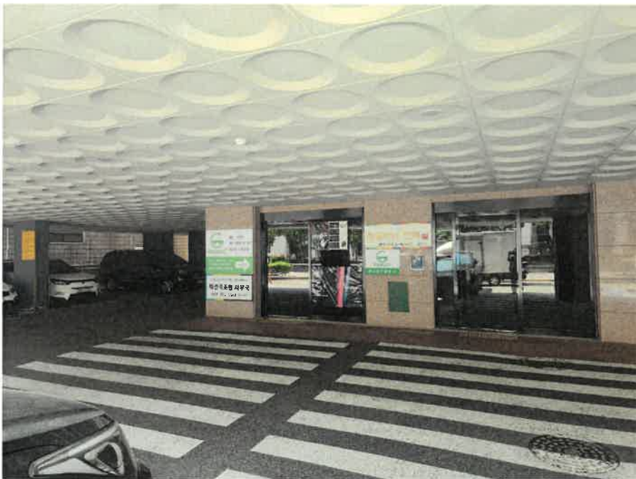
본건 1층 출입구
