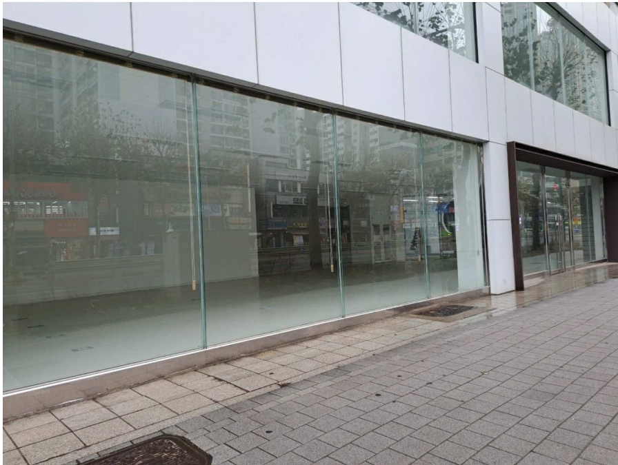
기호2 (협성빌딩 B동) 1층 전경
