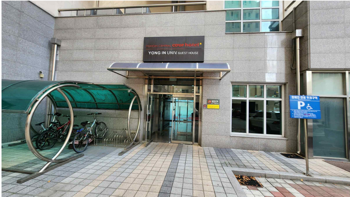
본건 소재 건물 1층 출입구
