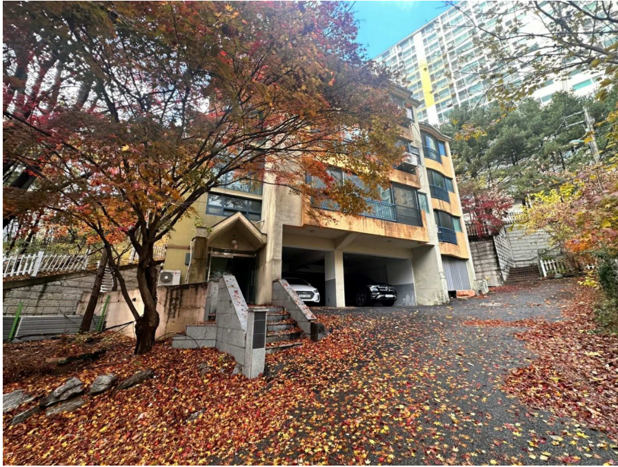
기호 3,4,5 : 필그린빌리지 4동 2층 201호, 3층 301호, 4층 401호
