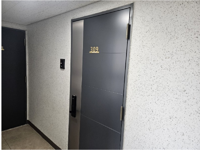
【본건 내부 출입문 전경】
