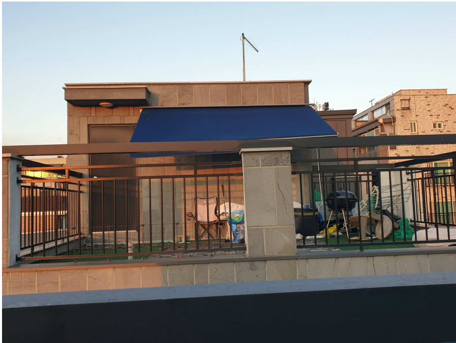
에이동 옥탑1층 계단실 모습 (난간 뒷쪽 좌측 건물)
