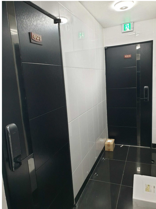
비이동 4층 403호~404호(무단증축부분)
