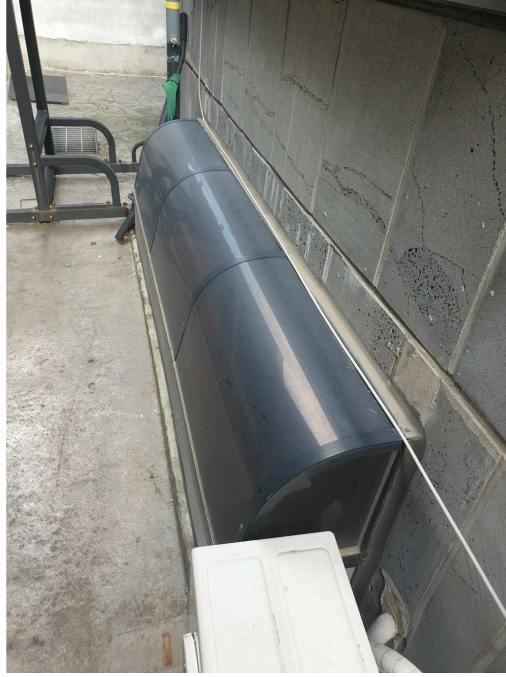
제시외물건 ㉔ 에이동 지하1층 상부 외 지상 소재 차양 모습
