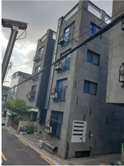
본건 비이동 남동측 전경
