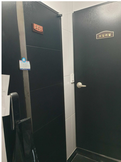
에이동 2층 201호 ~보일러실
