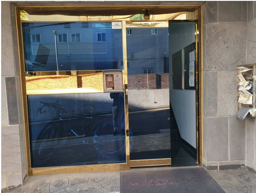
에이동 1층 전체 출입구 모습
