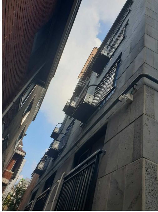
에이동 북서측 벽면 모습 (다수의 방범창 및 소형 실외기 거치대 소재함)
