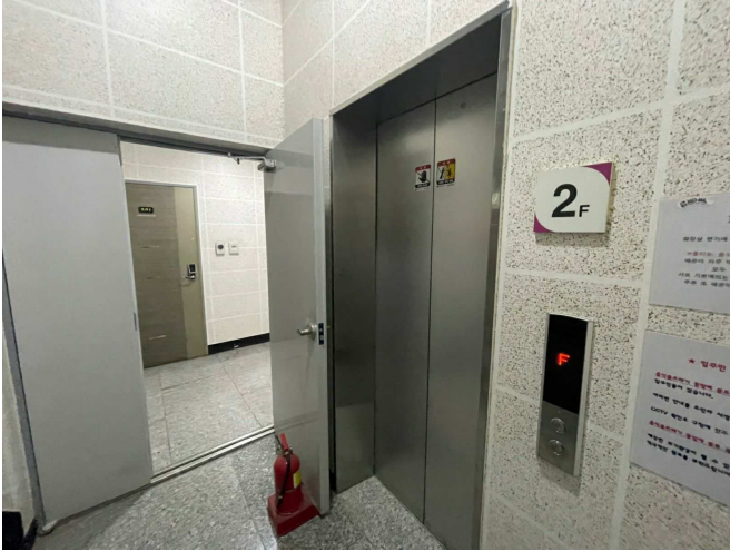
본건 건물 2층 입구
