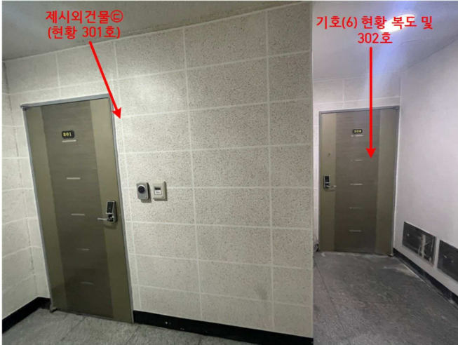
본건 기호(6) 301호(현황 복도 및 302호) 및 제시외건물㉠
