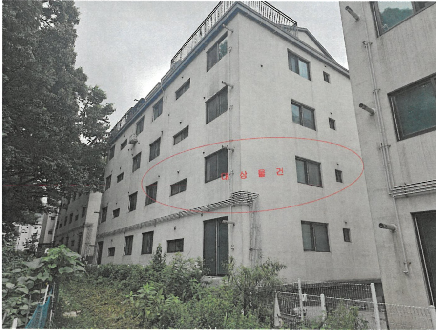
대상물건 후면 전경
