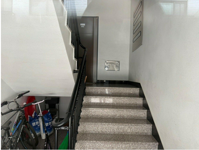
[ 동 1층 전경(102호) ]
