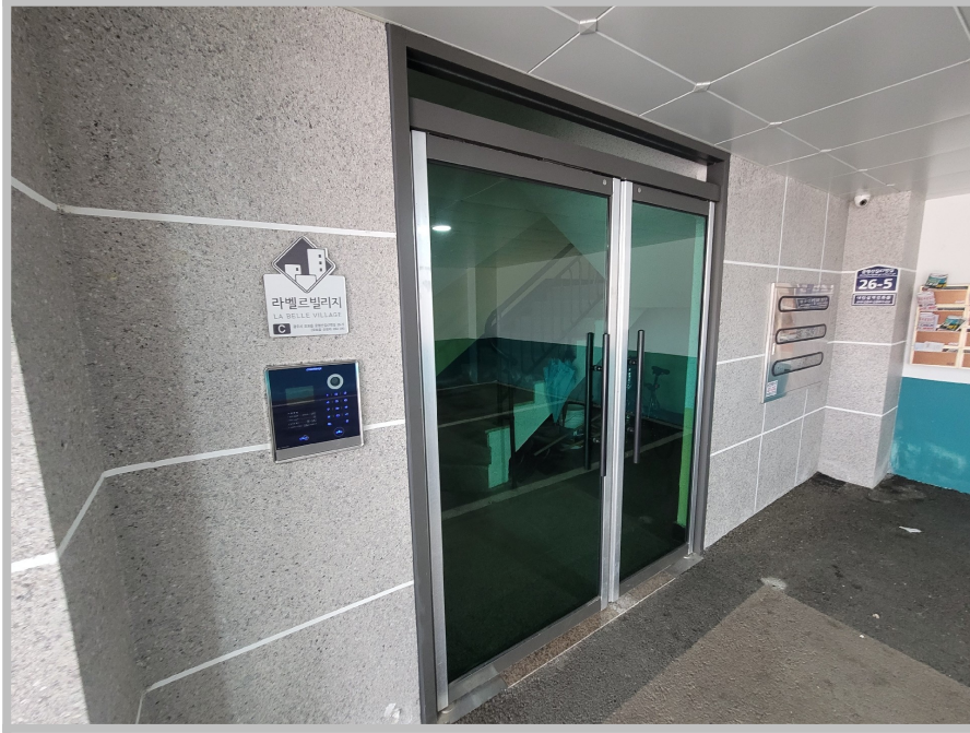
【 기호(4) 공동현관문 전경 】
