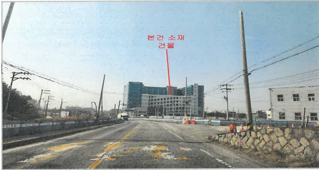
본건 전경(북동측 인근에서 촬영)
