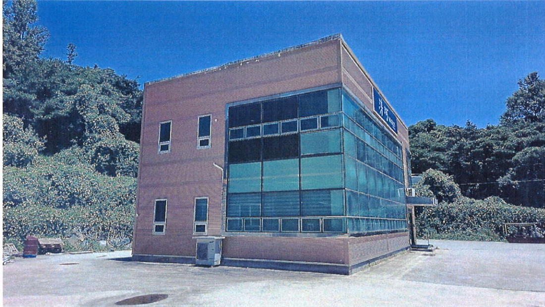
본건 건물 기호 2-3 사진
