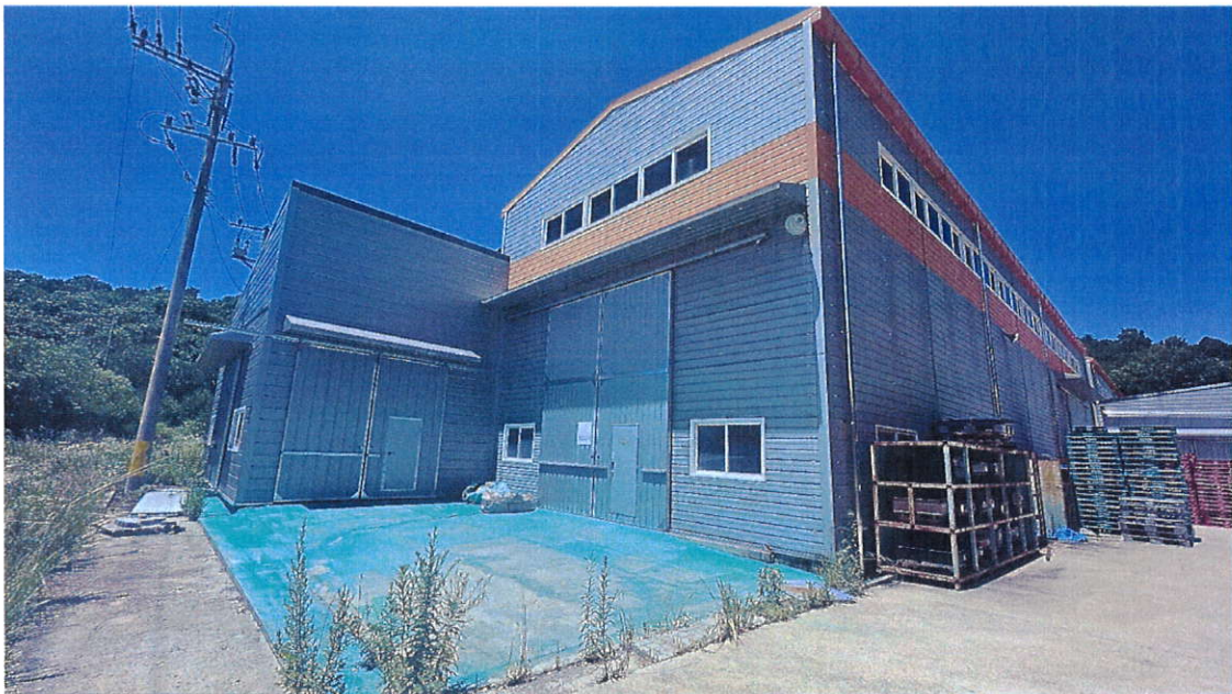
본건 건물 기호 3 사진
