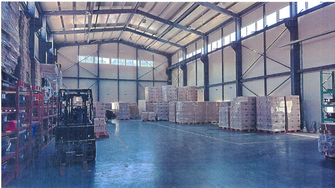
본건 건물 기호 4 사진
