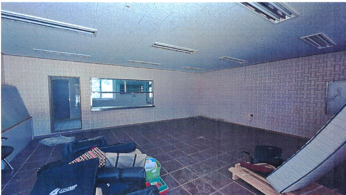
본건 건물 기호 2-2 사진
