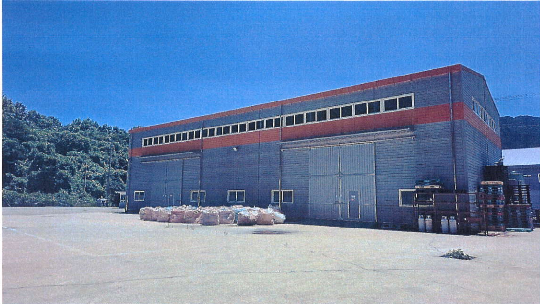
본건 건물 기호 4 사진
