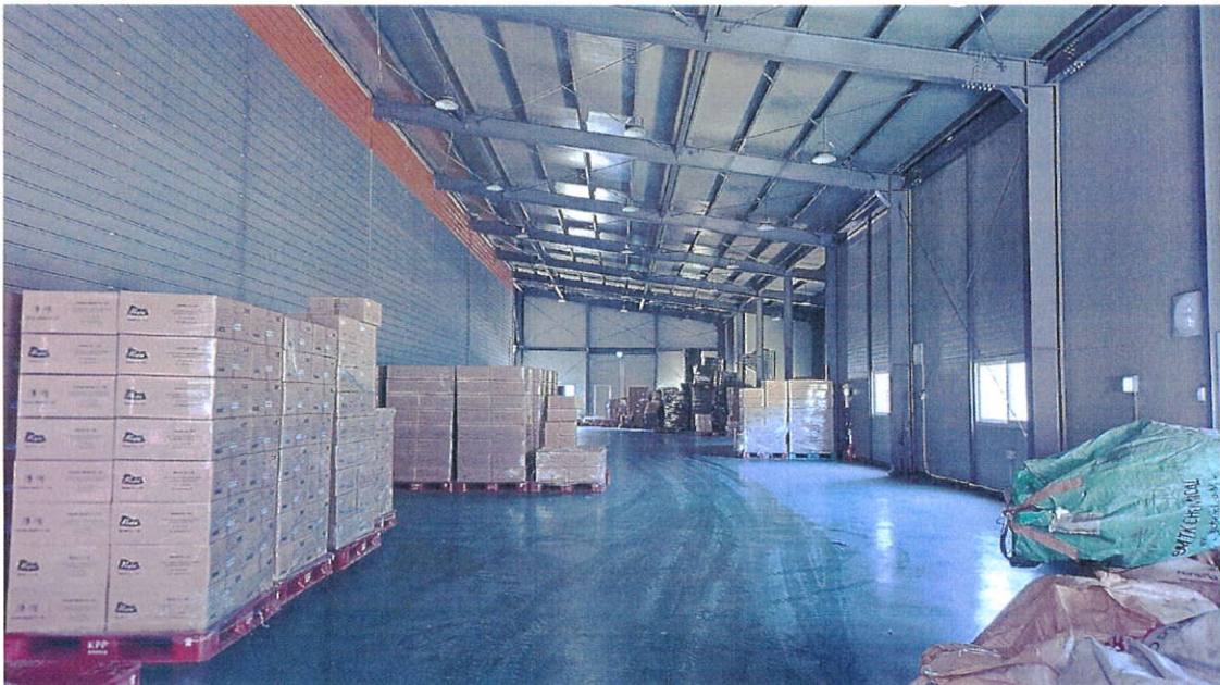
본건 건물 기호 3 사진
