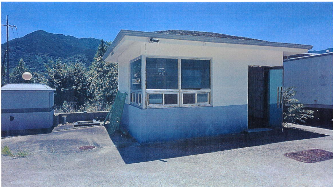
본건 건물 기호 2-4 사진
