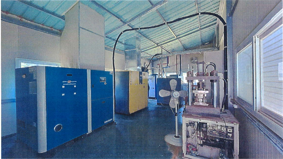
본건 건물 기호 2-5 사진
