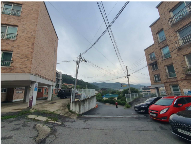
본건 현관문 전경
