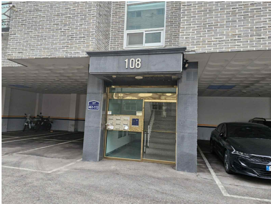
지하1층 공동 출입구 촬영
