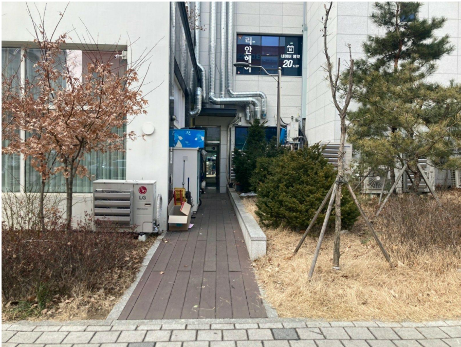
건물 동측 출입구 전경
