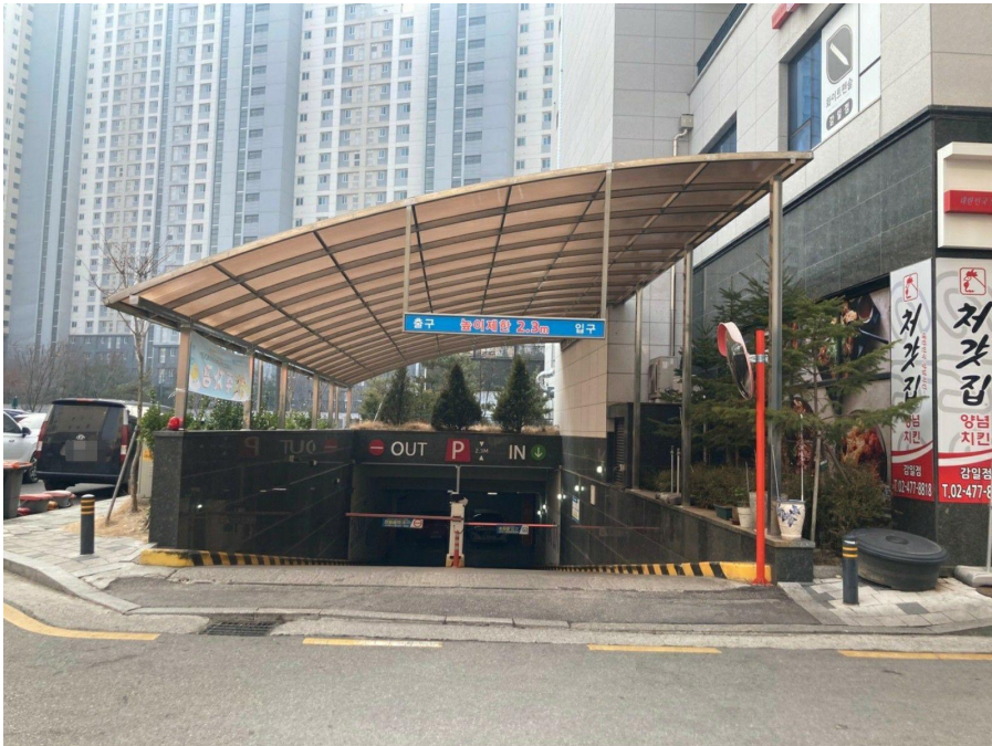
주차장 출입구 전경
