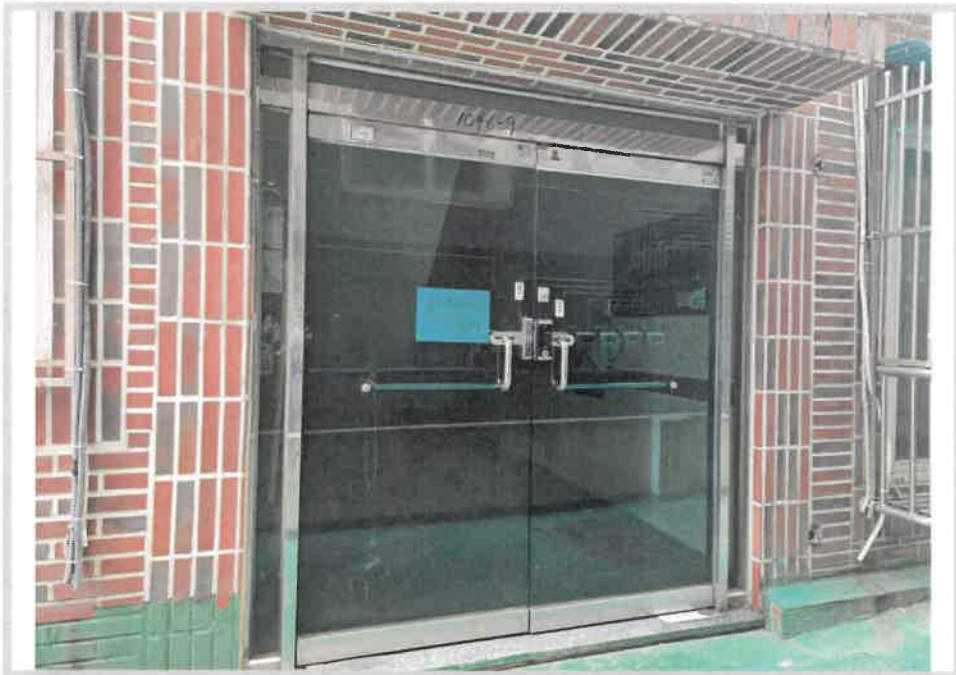
주 출입구 전경
