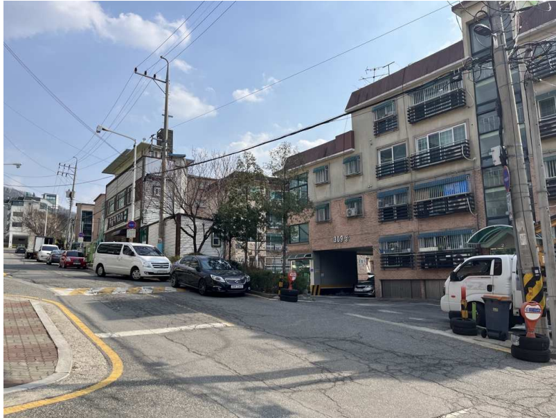
본건 소재 건물 전경 (북서측방면)
