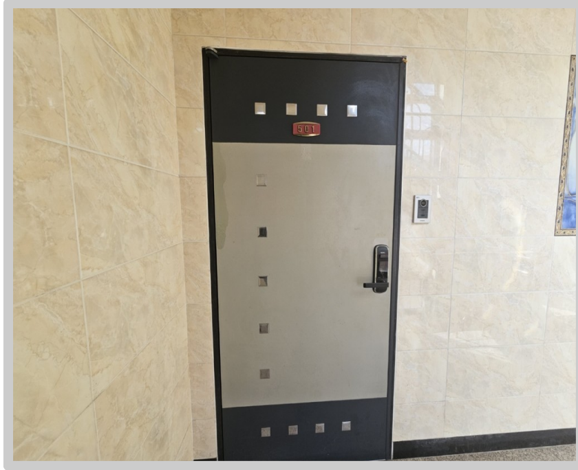
【 대상물건 501호 현관문 전경 】
