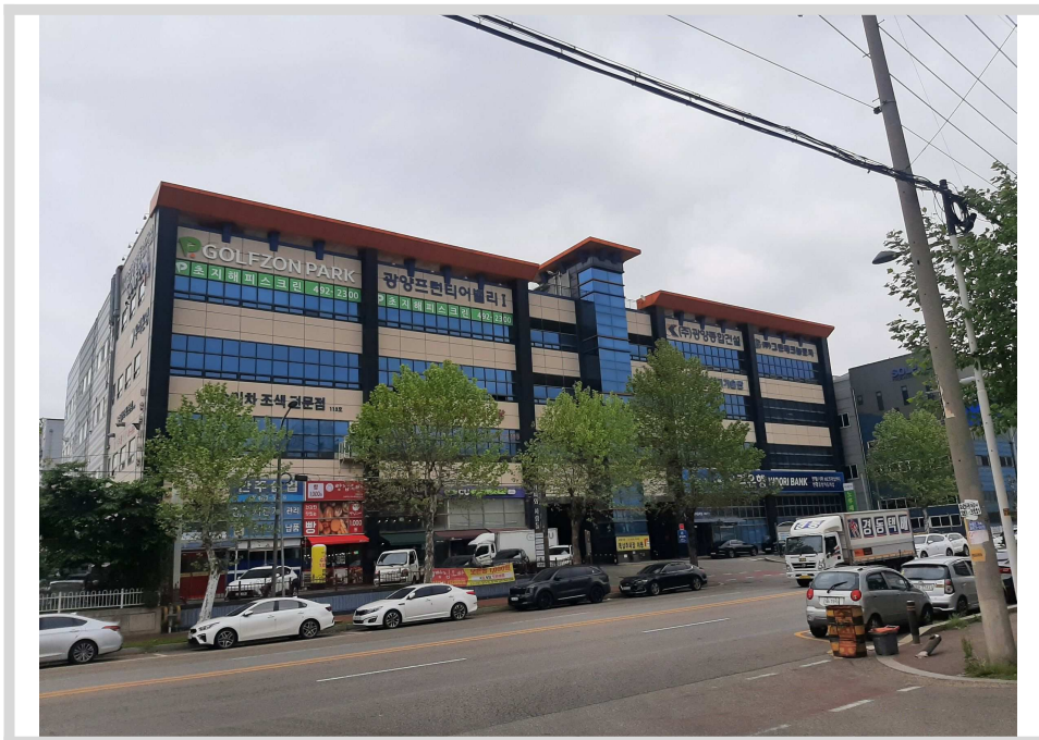
광양프런티어밸리 지식산업센터 제1동 남서측 전경
