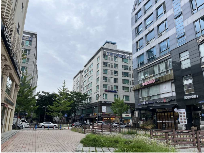
본건 소재 건물 전경 (북서측방면)
