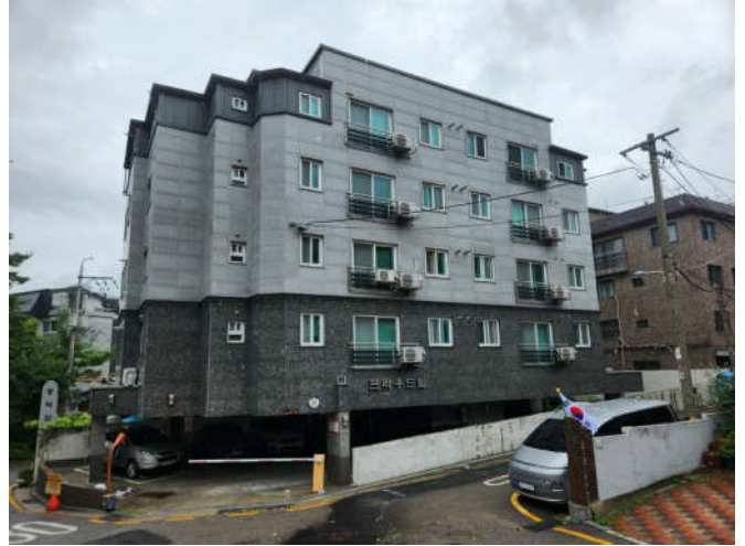
대상물건 소재 건물
