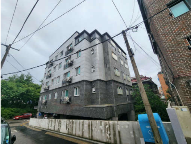
대상물건 소재 건물
