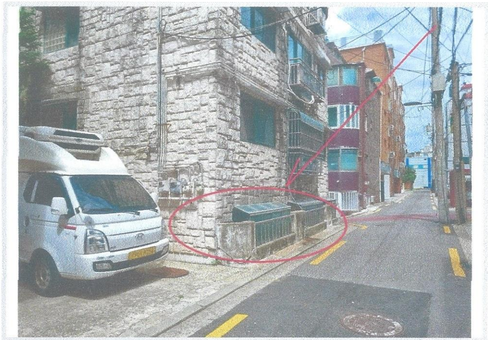
(통칭)동지아트빌라 및 본건전경(남서측에서 촬영)
