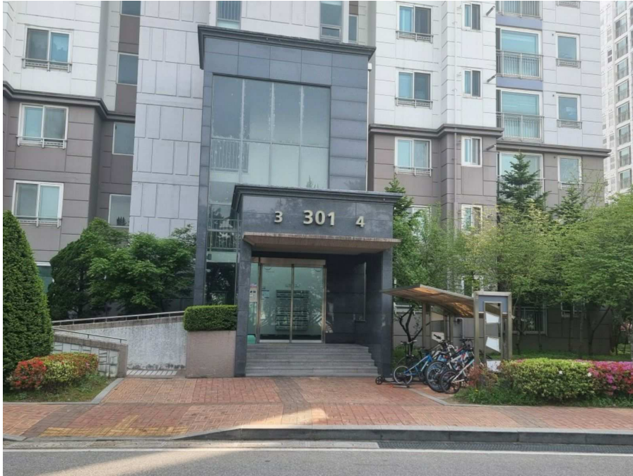
본건 301동 3,4 라인 1층 전경
