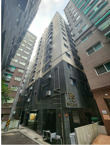
대상물건 소재 건물
