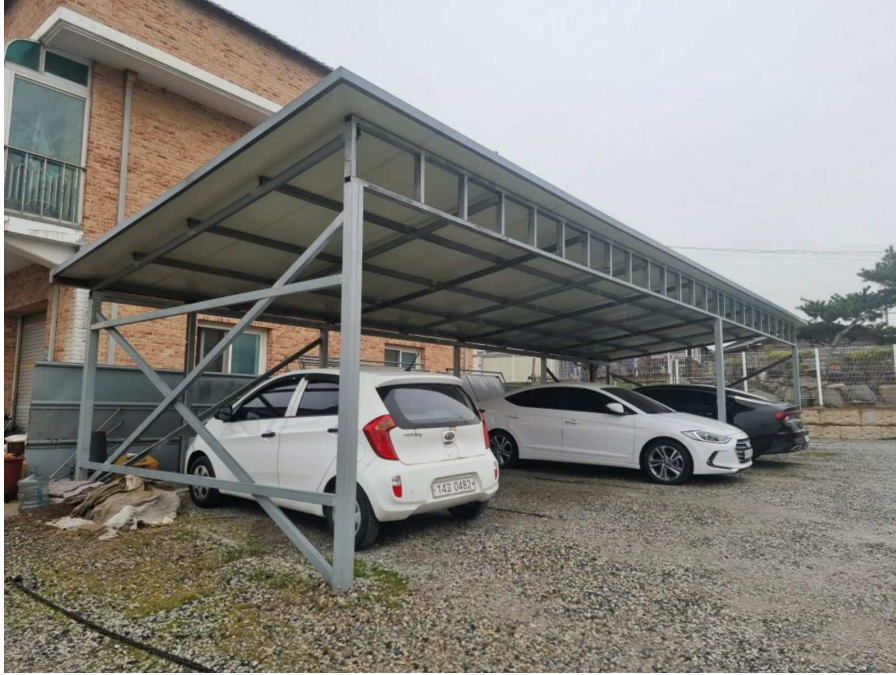
제시외 철골조 주차장 건물 기호(ㄱ)
