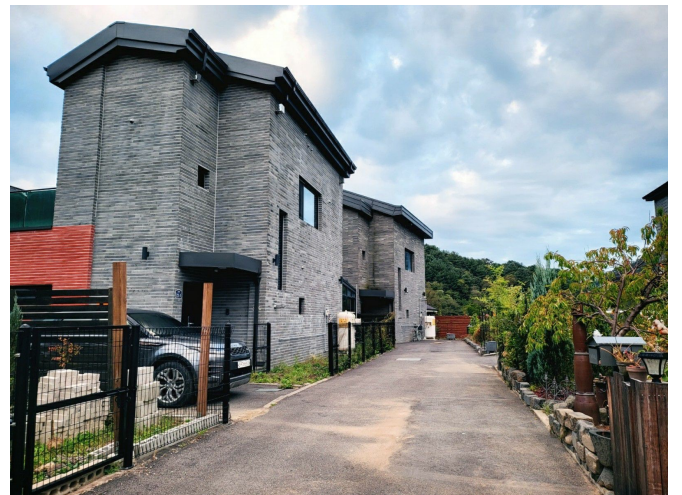
본건 및 주변 전경
