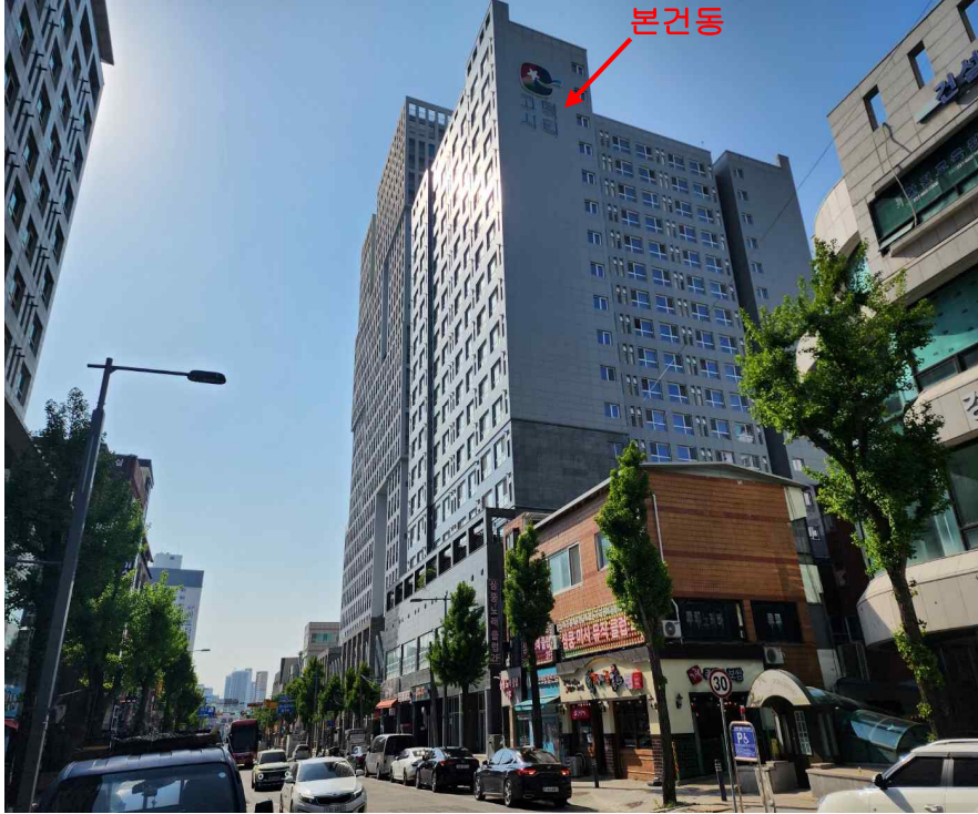
본건동 전경 (남동측에서 촬영)
