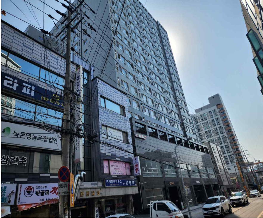
본건동 전경 (북동측에서 촬영)
