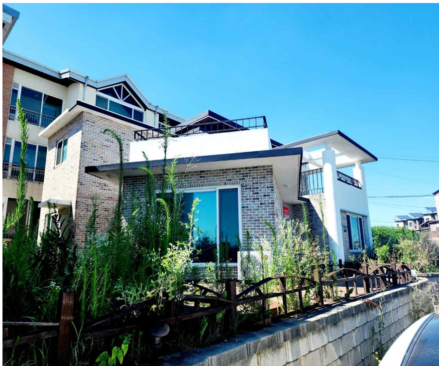
건물 기호2 전경 (남동측에서 촬영)
