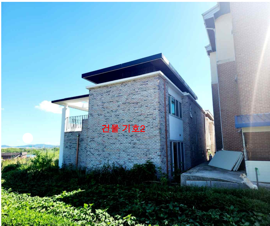
건물 기호2 전경 (북측에서 촬영)
