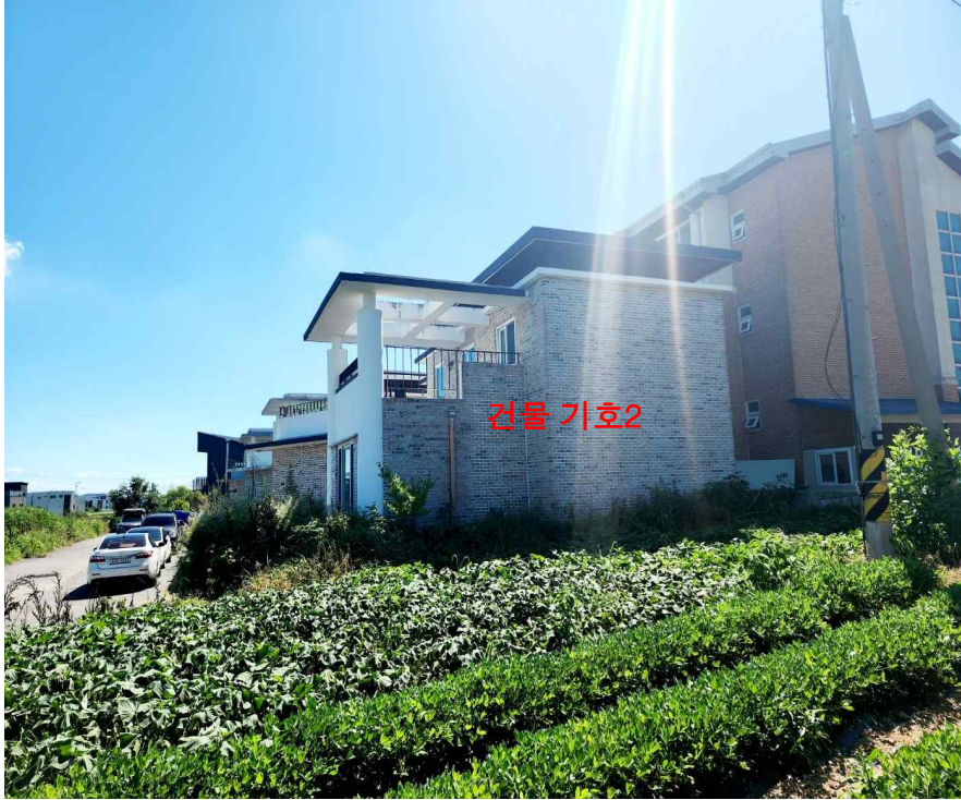
건물 기호2 전경 (북동측에서 촬영)
