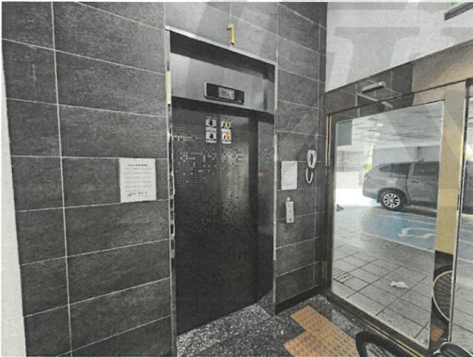
본건물 내 엘리베이터 전경
