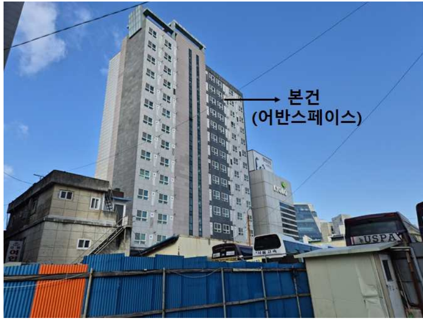
본건 전경(남동측, 건물후면)
