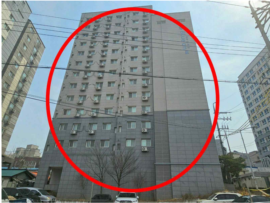
본 건 건물 전경
