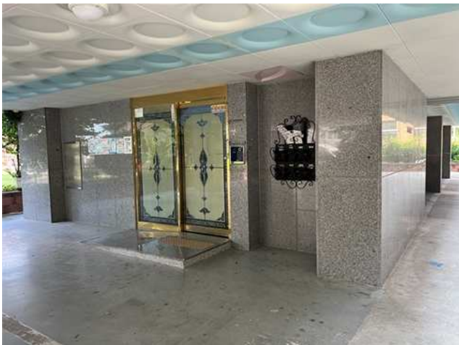
본 건물 출입구 전경
